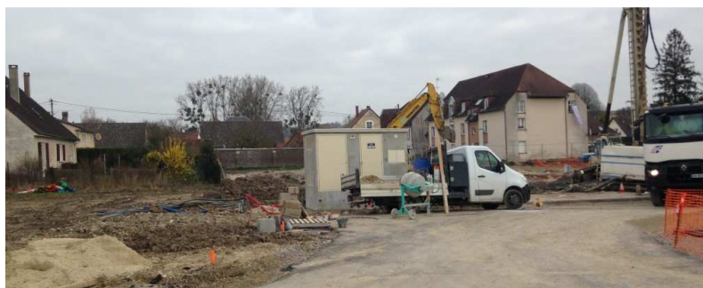
Poste de Transformation
